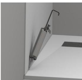
Mise en place du joint de finition souple fongicide.
